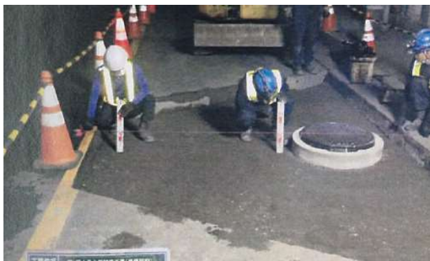
マンホールの補修工事の様子
