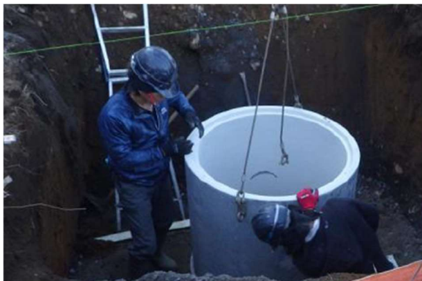
マンホールの設置工事の様子
