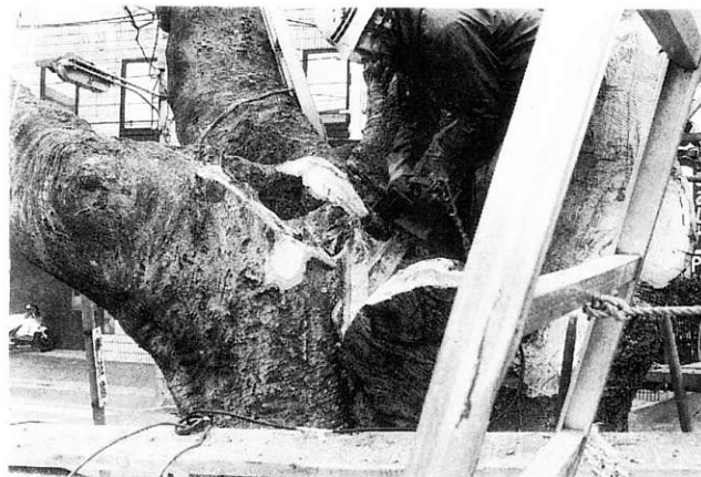
写真2 腐朽部分の削り取り（加藤榎）
