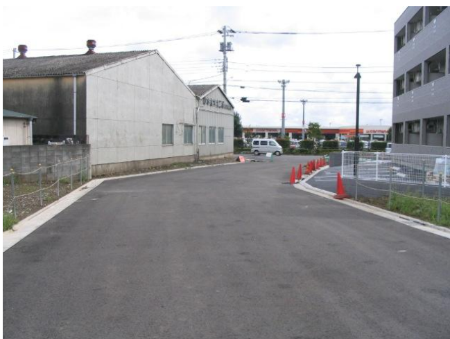
↑③区画道路築造第9号工事
