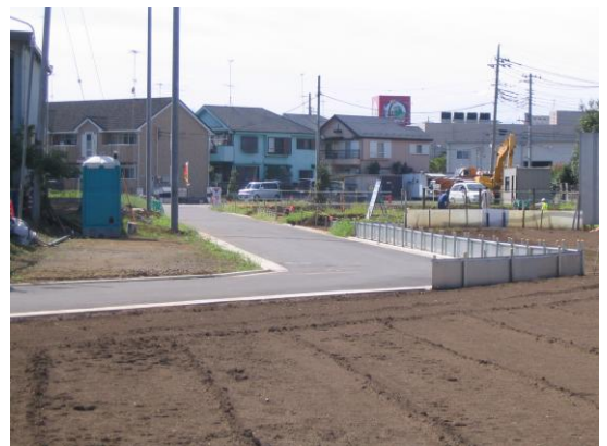
↓②区画道路築造第10号工事
