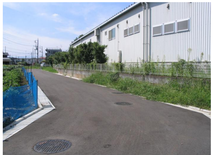
↑④区画道路築造第9号工事
