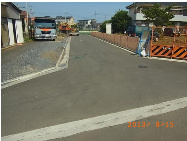
↑①区画道路築造第13号工事（幅員5m）
