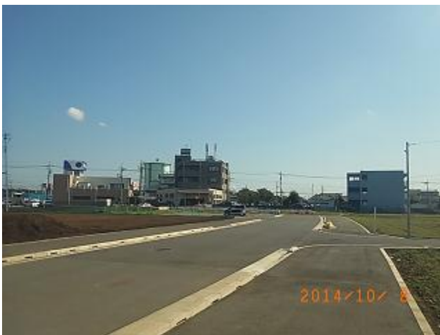
↑① 都市計画道路7・5・3号線築造（その3）並びに区画道路築造第15号工事
