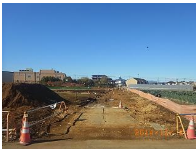
↑⑤ 区画道路築造第17号工事(幅員5m)
