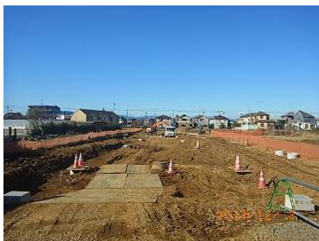
↑④ 都市計画道路7・5・3号線築造(その4)工事(幅員14m)
