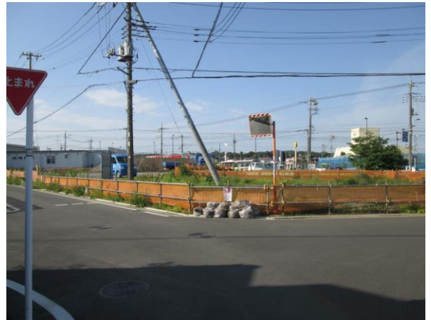
【（仮称） 3号公園（施工中）】
