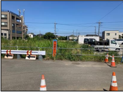
【令和5年度施工（路線東端）】
