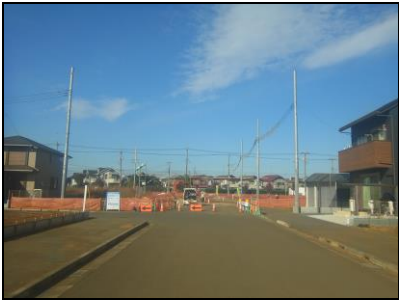
【令和4年度施工（路線西端）】
