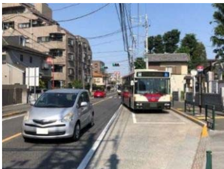
図 3-9 バス停留所（バスベイ）の設置例
