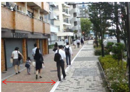
歩道有効幅員約3.5m
