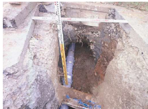
公共汚水柵の設置の様子
