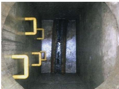
マンホールの内部
