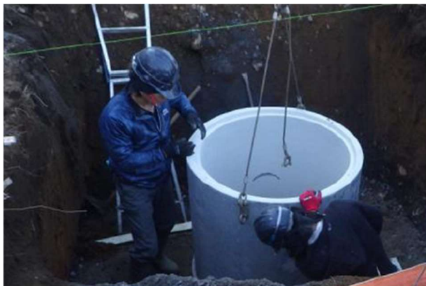
マンホールの設置工事の様子
