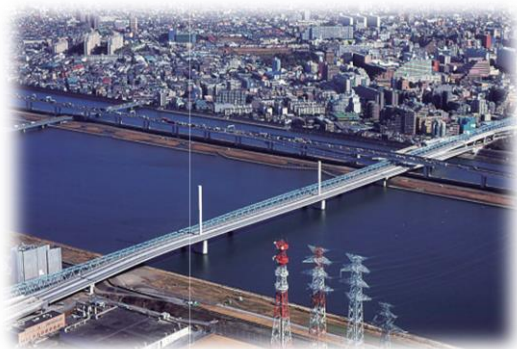
放射 16 号線（清砂大橋）〔平成 15 年開通〕 （江東区新砂）
