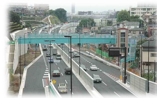
環状 8 号線〔平成 18 年開通〕 （板橋区若木）
