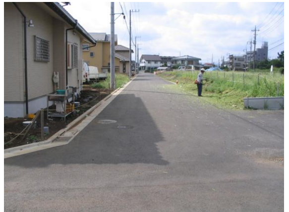
↓②区画道路築造7号工事（平成21年度施工）
