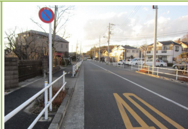
道路舗装、道路附属物等
