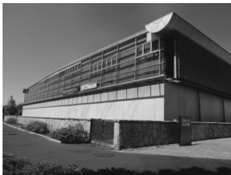
総合体育館（外観）
