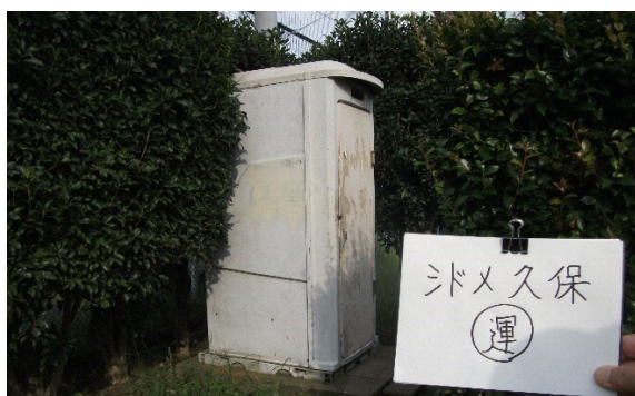
事例写真⑪ 全景（シドメ久保運動広場便所）
