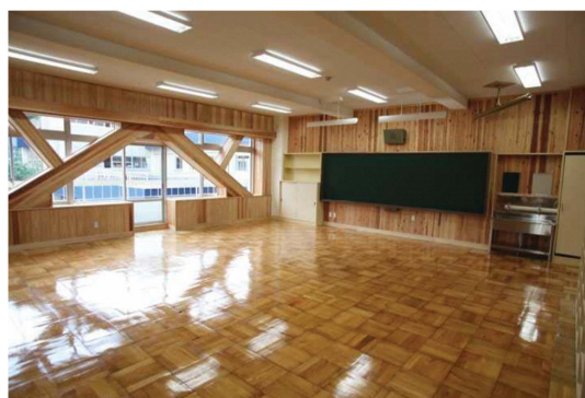
老朽化対策において内装に木製素材を使用した例 (茂木町立茂木小学校)
