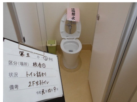
排水設備：トイレ詰まり (c)
