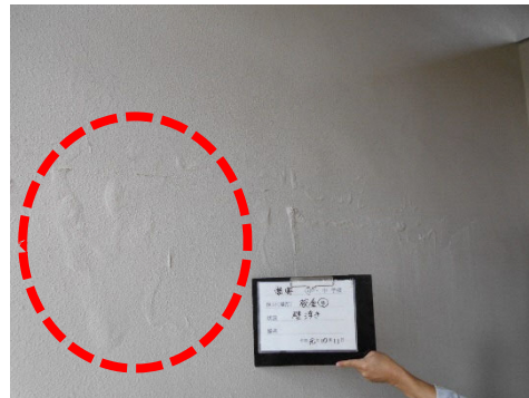
内部壁：浮き (b)
