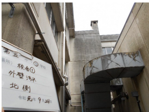
外壁：汚れ (b)
