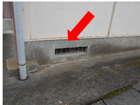
基礎・土台：ひび (c)
