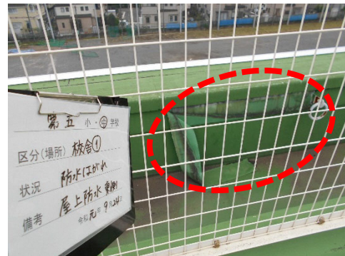
屋上：防水シート剥がれ (d)
