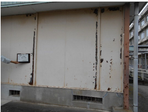
外壁：さび (c)
