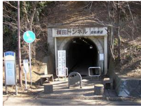
横田トンネル(出典:武蔵村山市)
