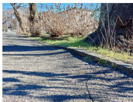
野山北公園自転車道の舗装 （出典：武蔵村山市）
