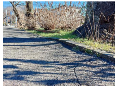
野山北公園自転車道の舗装 (出典:武蔵村山市)
